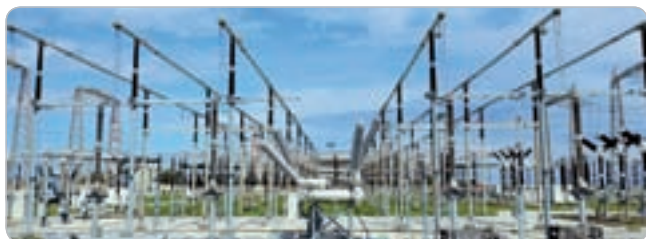
Obr. 1 Doplnenie 400 kV poľa prostredníctvom modulu PASS do existujúcej konvenčnej rozvodne
