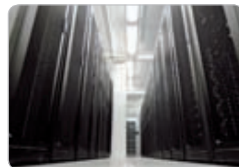
Obr. Dátové centrum prevádzkované spoločnosťou SafeData v Moskve (Zdroj: SafeData)
